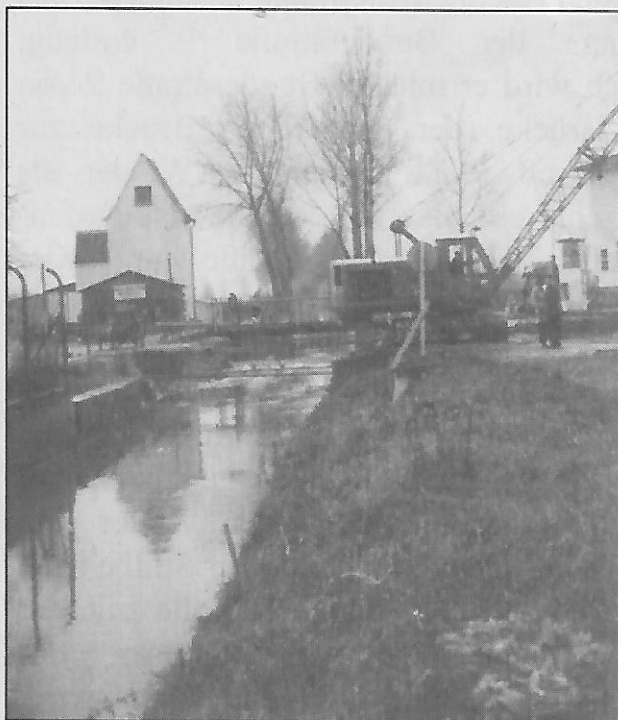
Die Bachbrück an der Jahnstraße wird verbreitert
