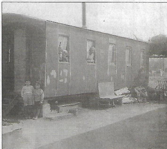
Ausgediente Eisenbahnwaggons zum Eindämmen der Wohnungsnot
