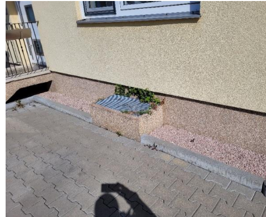
Konstruktive Erhöhung von Lichtschächten
