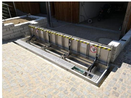
Klappschott – Schutzklappe um 90° aufrichtend
