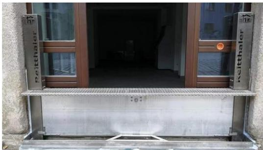
Vertikalschott – Schutzklappe horizontal nach oben ausfahrend
